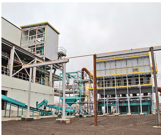
▲ На «Цинкуме» уже возведены некоторые корпуса и идёт монтаж оборудования
