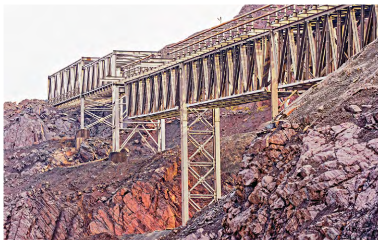
▲ На МГОКе продолжают строительство второй очереди дробильно-конвейерного комплекса
