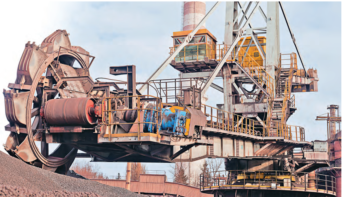
▲ Новая машина работает и на складирование, и на забор окатышей со склада в погрузочный бункер
