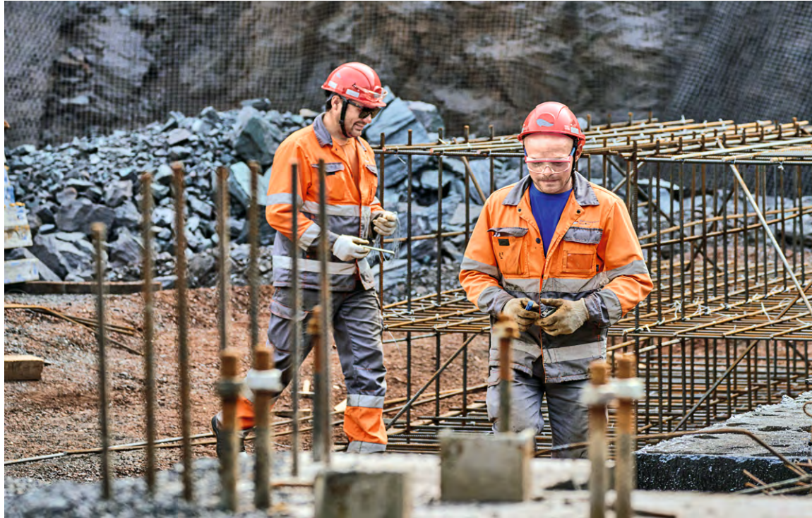
▲ Специалисты Рудстроя монтируют арматурный каркас фундаментной плиты дробильно-перегрузочного устройства
