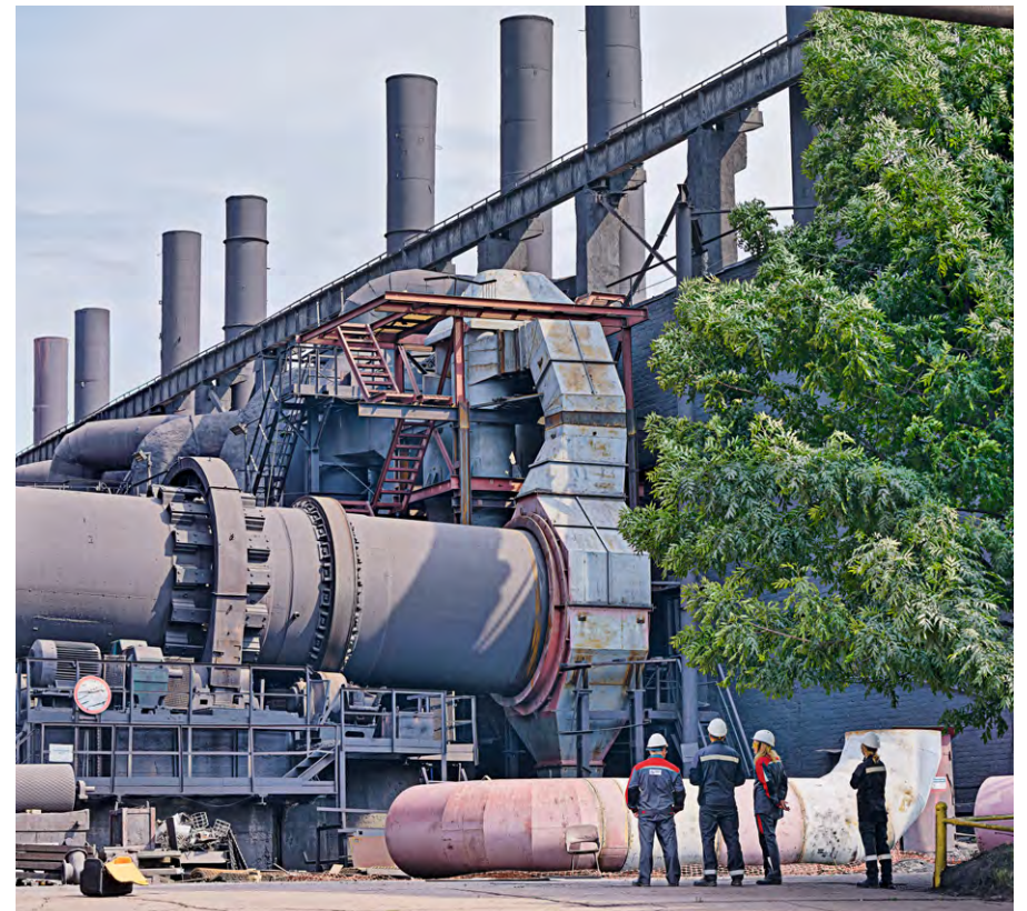
▲ Монтаж основных элементов сухой очистки печи № 1 уже практически завершён
