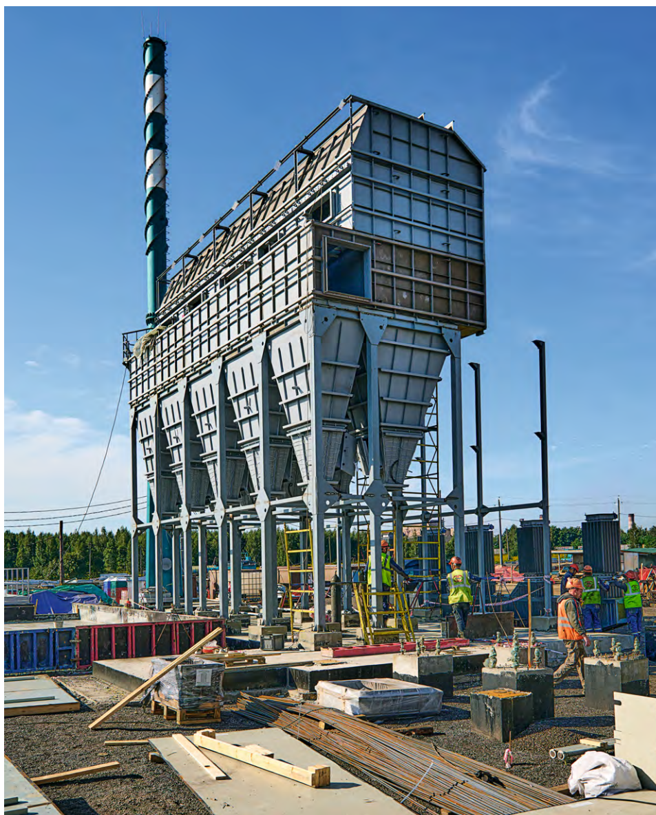
▲ В Железногорске полным ходом идёт строительство завода «Цинкум»
