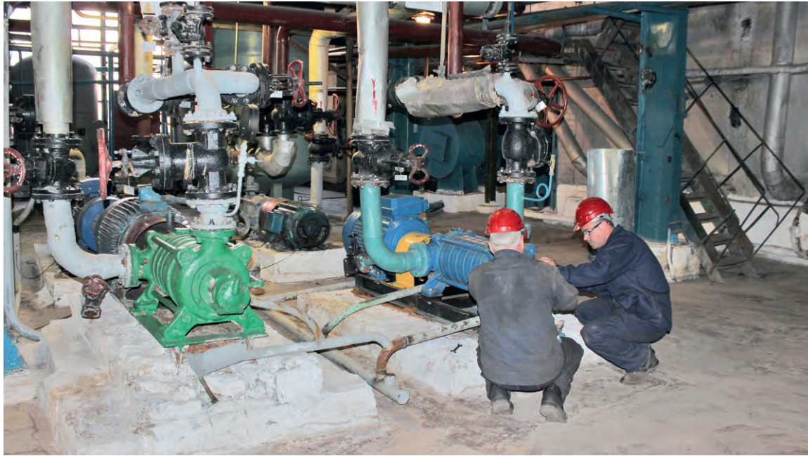
▲ Выполненные работы направлены на бесперебойное снабжение теплом всех подразделений комбината
