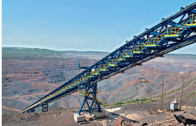
фективность работы комбината. По размерам и конфигурации крутонаклонный конвейер ДКК униклен для нашей страны: его угол наклона — 37 градусов, высота подъёма — 215 метров.
