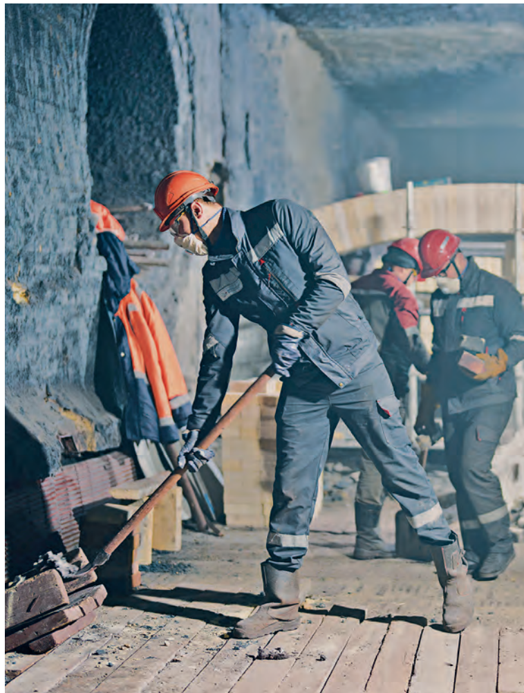
▲ Бригады Рудстроя сбивают старую огнеупорную футеровку обжиговой печи и выкладывают новую, обновляя «внутреннюю броню» машины
