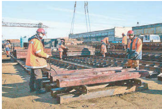
Капитальный ремонт железнодорожного полотна включает в себя полную замену рельсо-шпальной решетки
