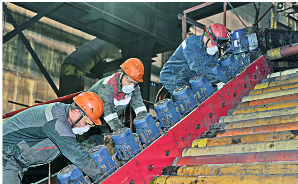
▲ 18 дней в круглосуточном режиме на участках ОМ-2 параллельно работали 34 бригады сотрудников управления по ремонту механического и электроэнергетического оборудования
