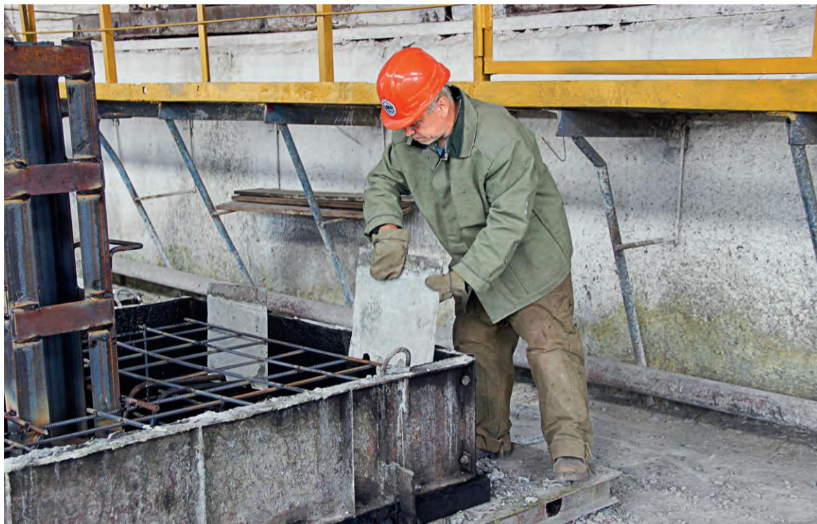
**Н**а дробильно-сортировочной фабрике идут работы по усилению фундамента сушильного барабана №2. Проводит ремонтные работы бригада мастера строительно-монтажных работ ЦМР Сергея Мяснянкина. — Со временем фундамент оседает, образовываются поры, которые мы и заполняем бетоном, чтобы основание здания не разрушалось. Работы по времени займут порядка
