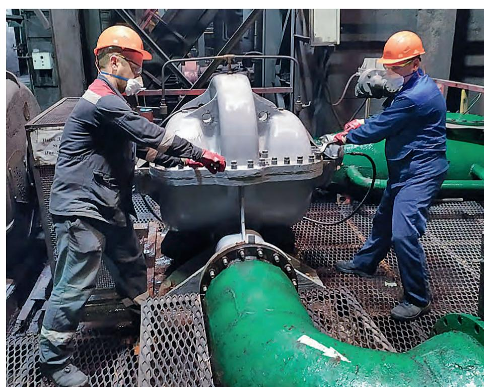
▲ Смонтированный насос изготовлен с конструктивными изменениями, облегчающими его техническое обслуживание
