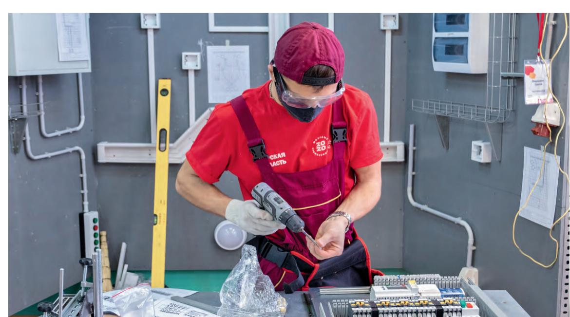
▲ В компетенции «Электромонтаж» нужно собирать несколько функциональных блоков — щитов, куда входят проводка, кабель-каналы, электродвигатели и другое оборудование
