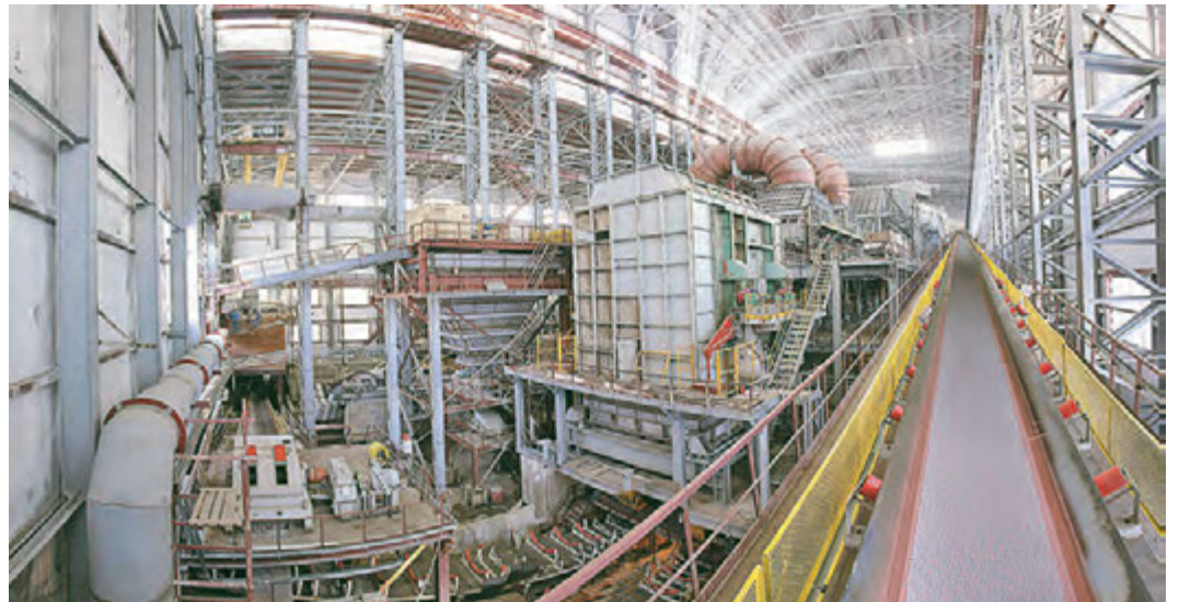
Инженеры Михайловского ГОКа проявили свое мастерство в пуско-наладочных работах на ОМ-3.
