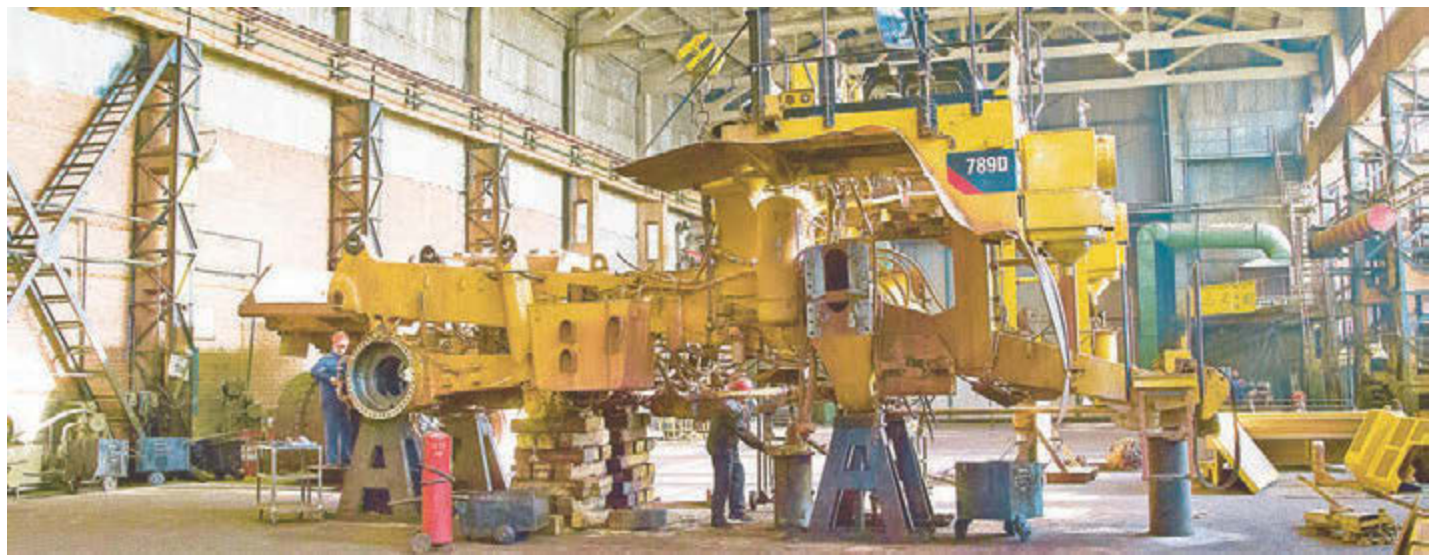
В этом году в управлении автомобильного транспорта капитально отремонтировали 180-тонные самосвалы
