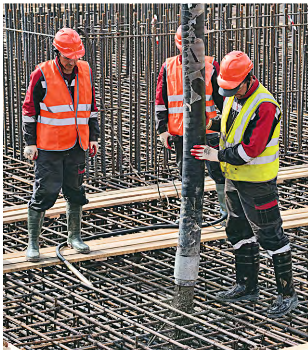
▲ Первые кубометры бетона — в основание современного и высокотехнологичного предприятия
