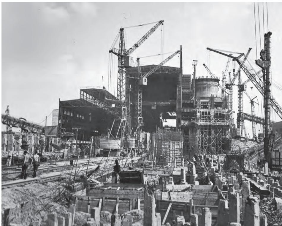
▲ Стройплощадка ФОК. Монтаж корпуса обжига и корпуса дымососов № 1. Сваи забиты под корпус грохочения.
