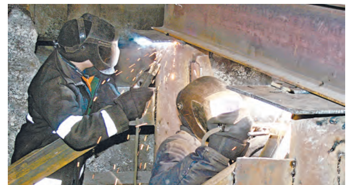
У сварщиков на подобных ремонтах работы всегда непрерывно
