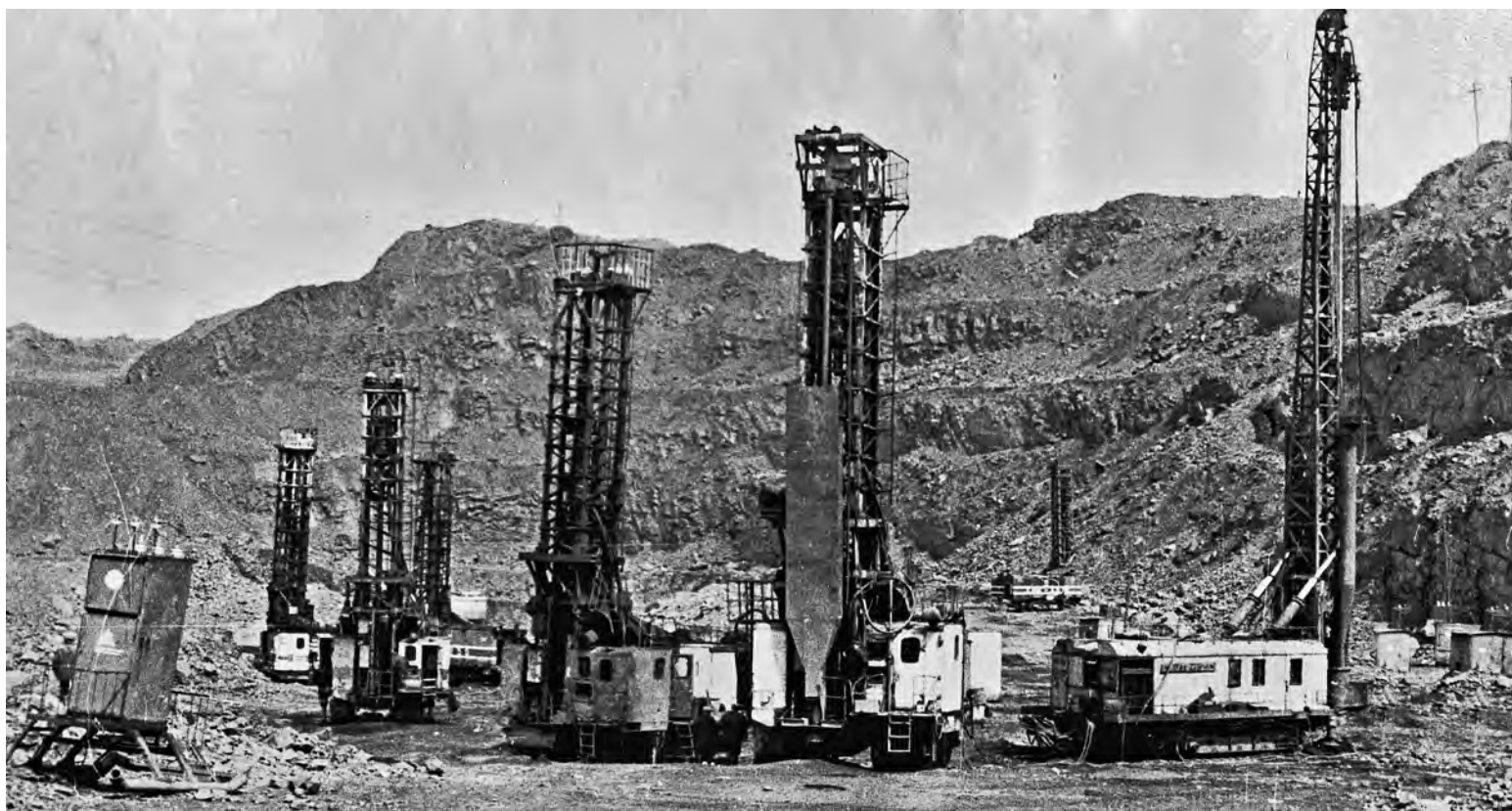
▲ Станки огневого и шарошечного бурения в карьере Михайловского ГОКа, 60-е годы
