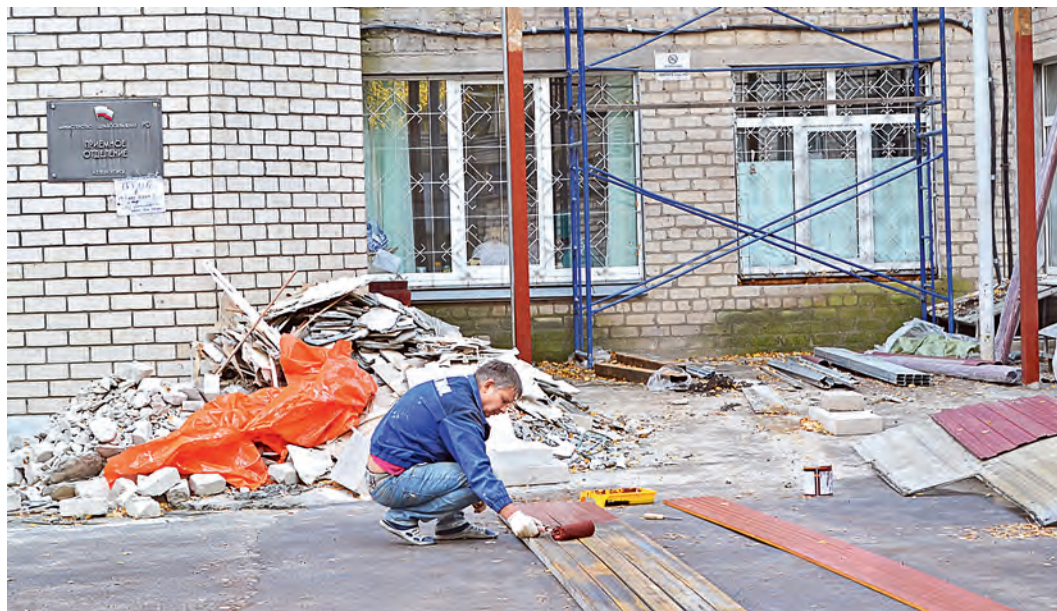
Ремонт медучреждений находится в стадии демонтажа устаревших конструкций.
