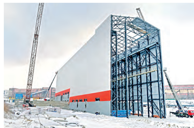
▲ Идёт обшивка каркаса здания приводных и натяжных станций магистральных конвейеров № 1 и № 2
