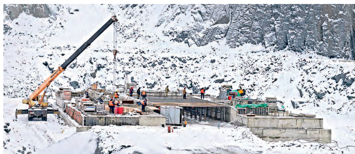
▲ На нижней отметке карьера продолжается подготовка площадки для узла перегрузки № 1
