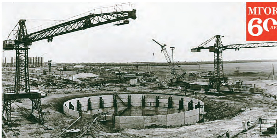
Строительство фабрики окомкования велось быстрыми темпами.
