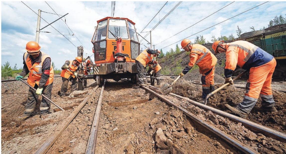
▲ При ремонте железнодорожного полотна используют всё: и спецтехнику, и ломы, и лопаты
