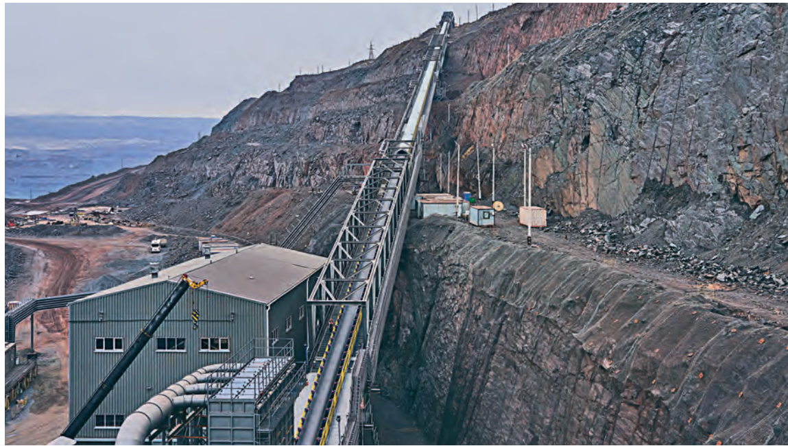
▲ Новый дробильно-конвейерный комплекс позволит повысить производственные показатели комбината
