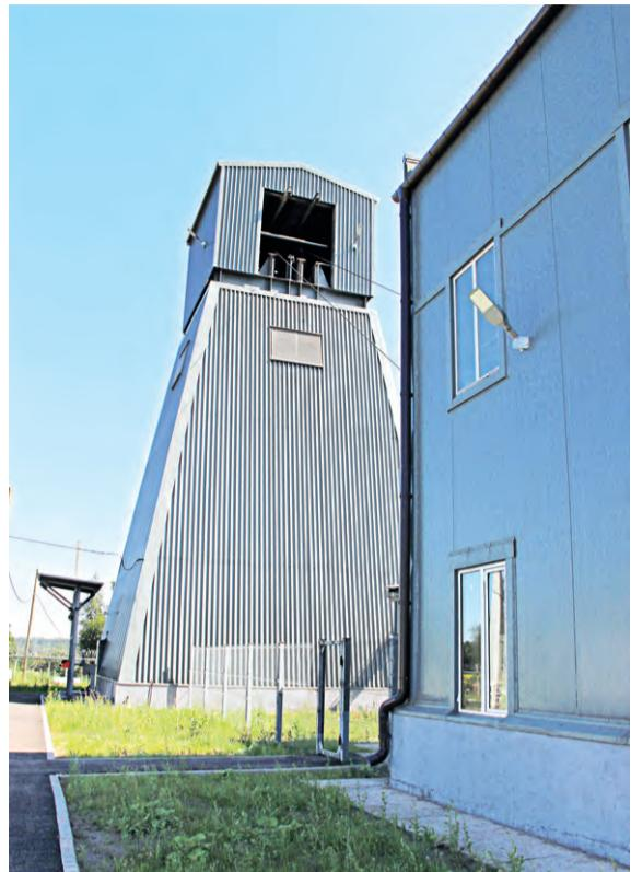
Подземный дренажный комплекс Михайловского ГОКа осуществляет осушение карьера для обеспечения возможности добычи полезных ископаемых открытым способом. Отвод воды проводится через сеть шахтных выработок путём бурения водопоникающих и водосбросных скважин. Годовой водоотвод составляет около 21 млн кубометров в год.
