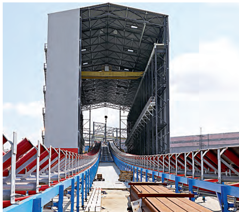
▲ Строительство важного объекта комплекса циклично-поточной технологии — здания приводных и натяжных станций
